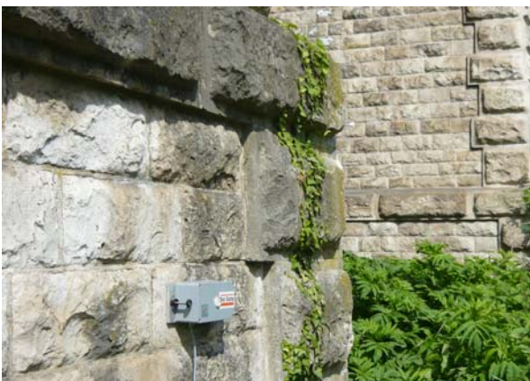
7 géophones 3D installés sur les piles du viaduc assuraient le suivi vibratoire en temps-réel
