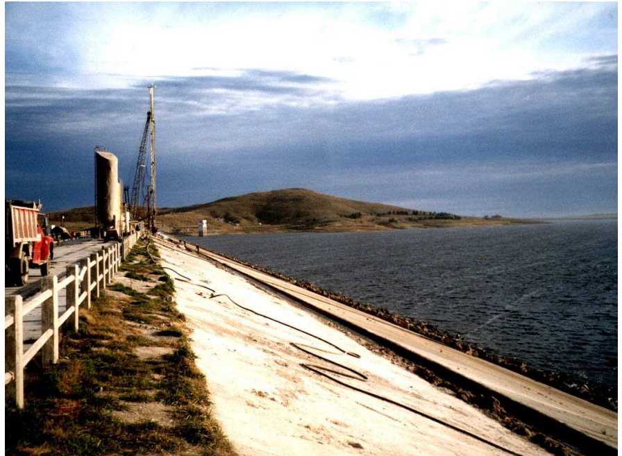
Presa en terraplén del Paso de las Piedras
