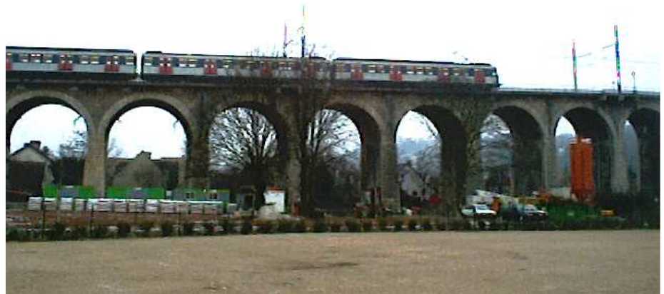
La Vallée Viaduct – RER A
