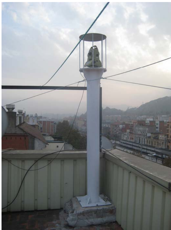
Vista del sistema de control mediante Cyclops
