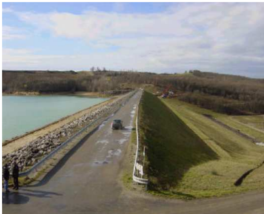
Le barrage de la Ganguisse depuis la rive droite avant les travaux de rehausse.
