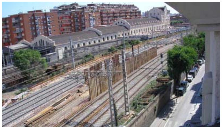
Vista de parte del tramo auscultado.
