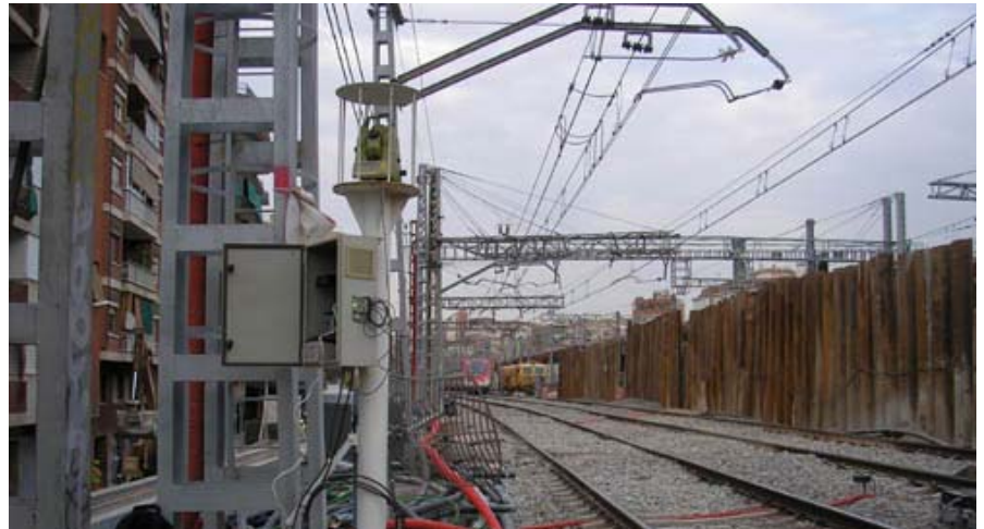
Fotografía del AC04, uno de los 8 teodolitos de la Obra.
