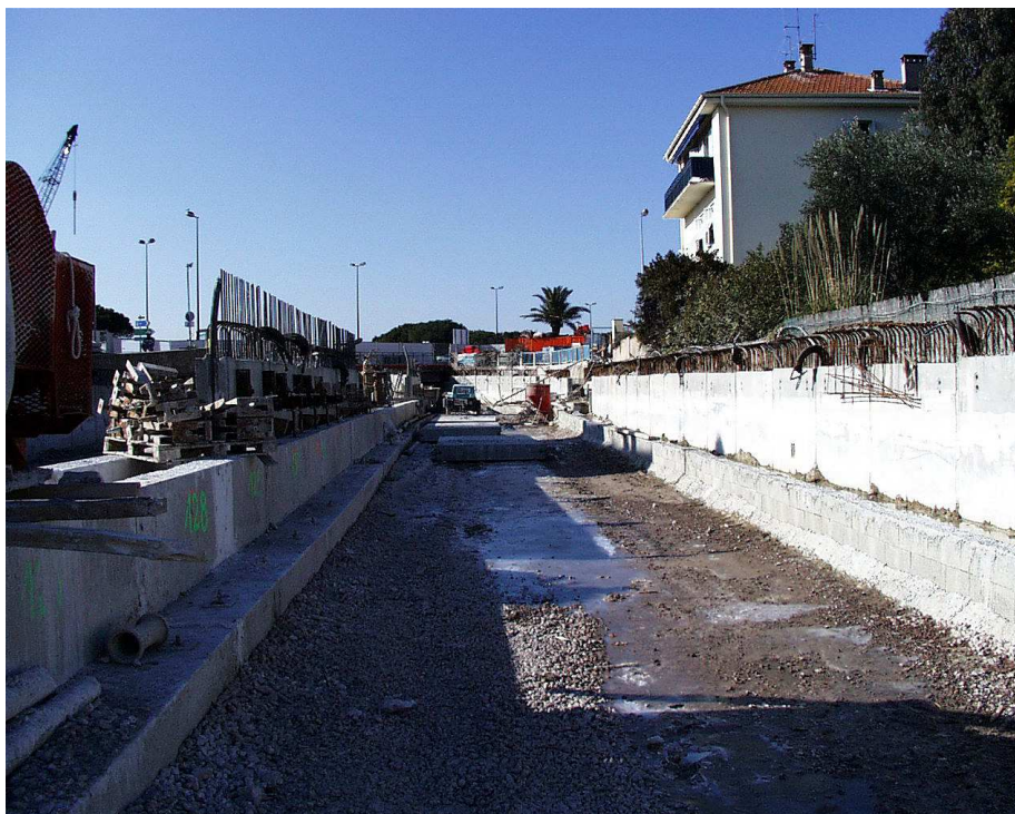
Vue du bief sec pendant la surveillance
