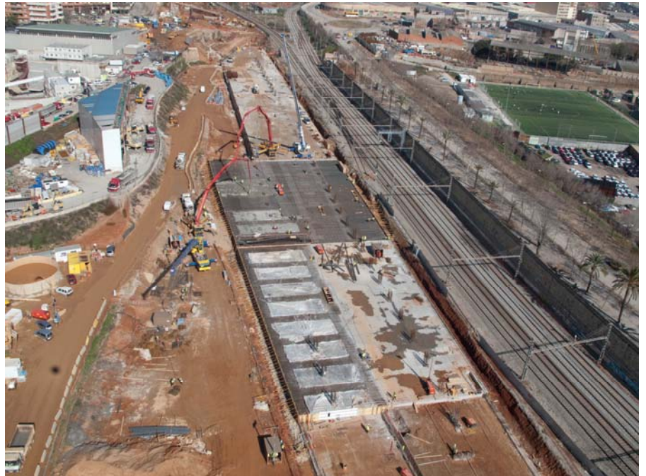
Vista general de la obra, en superficie.
