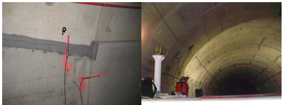
Prisma y fisurómetros para control de juntas entre dovelas y vista del túnel instrumentado
