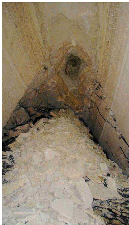
Exemple de fontis et d'éboulements présent à Triel sur Seine
