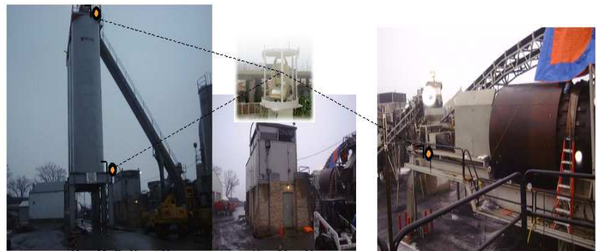
Surveillance d'une structure sensible pendant les travaux d'injection
