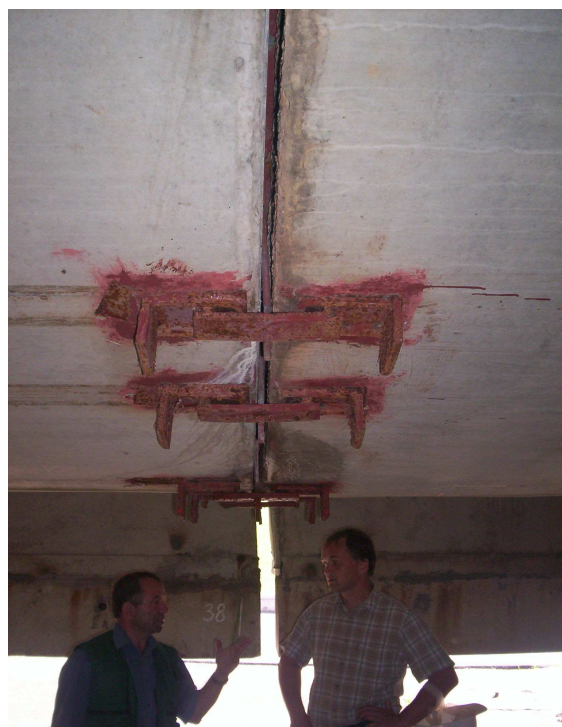
Expertise des possibilités de mise à niveau en fonction des besoins
