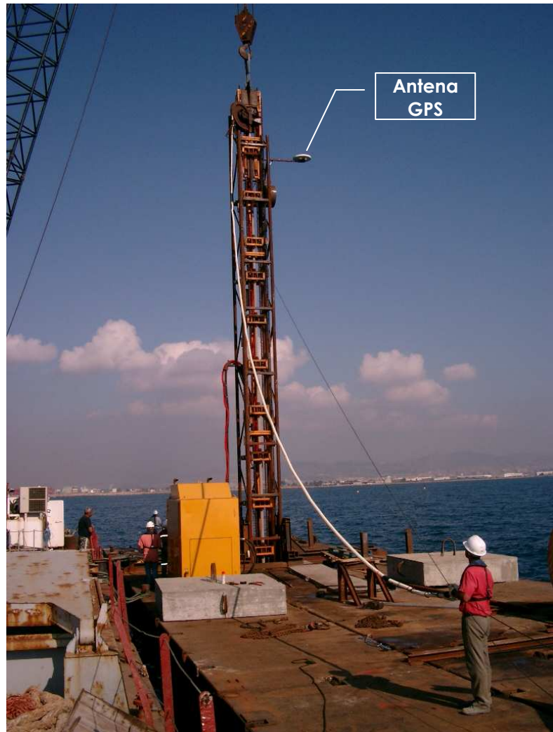
Colocación de los instrumentos mediante una hinca estática desde un pontón
