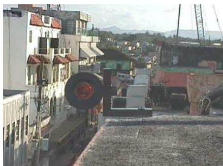
Cible prisme fixé au sommet d'un bâtiment
