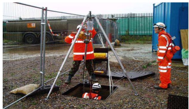
Ci-dessus: L'équipe d'installation en espace confiné descend dans le tunnel avec un trépied et un brise chute.
