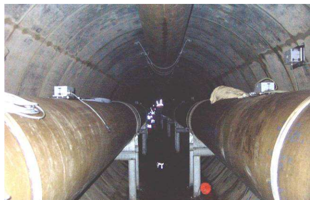
Ci-dessous: vue de l'intérieur du tunnel montrant les rangées de géophones.
