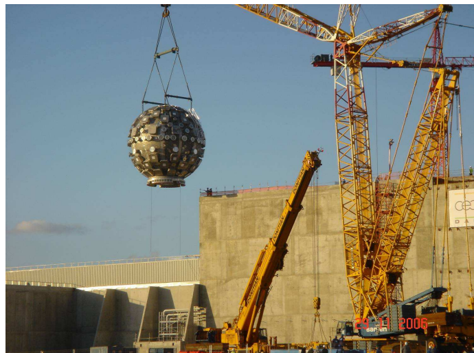
Installation de la sphère d'expérience
