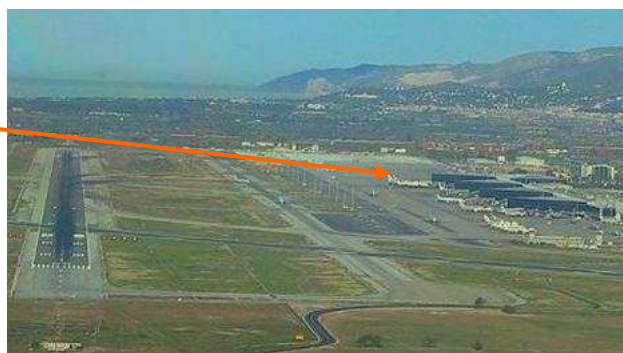
Aeropuerto Internacional de Barcelona
