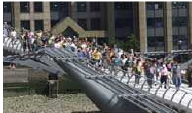
Test de chargement effectué avec 120 personnes
