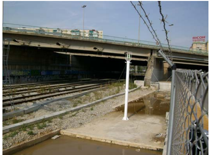
Sistema Cyclops controlando las vías de ferrocarril
