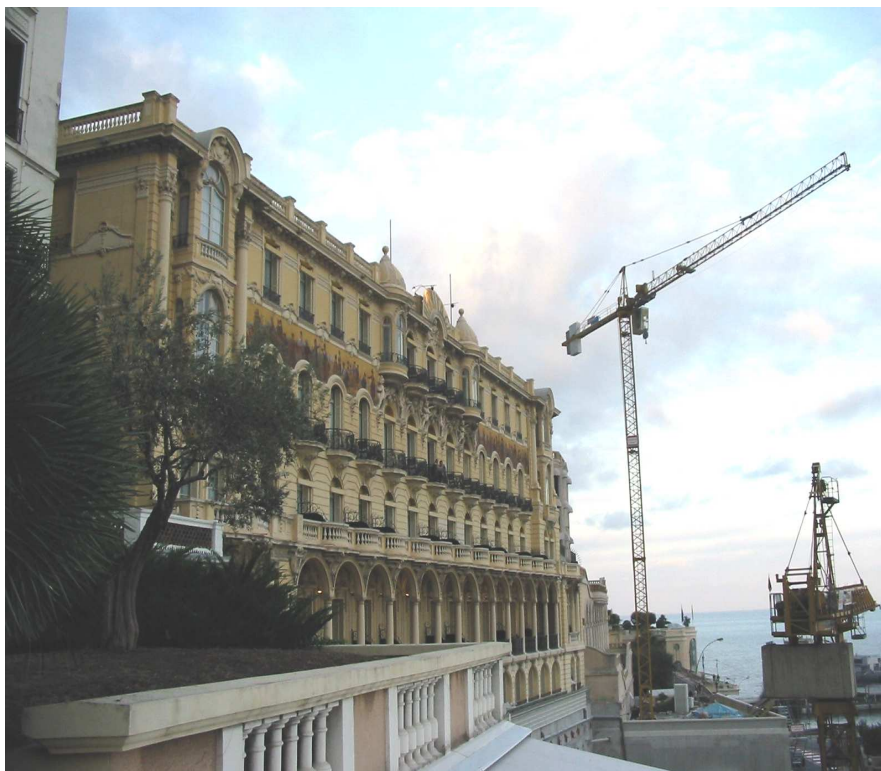
Vue de l'Hôtel l'Hermitage. Les 16 capteurs triaxiaux ont été installés sur les structures architectoniques du bâtiment.
