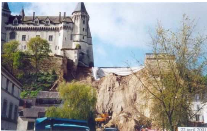
Derrumbamiento de la muralla norte tras el desmoronamiento de su terreno de soporte
