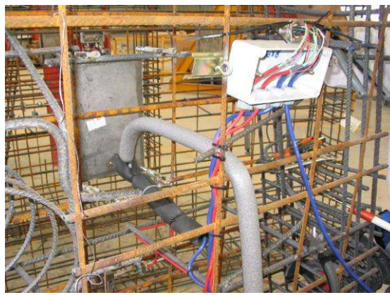
Cellule de pression totale et coffret de raccordement
