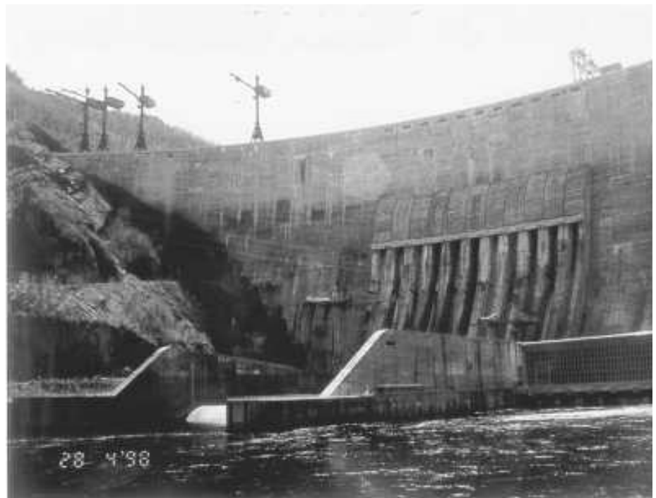
Barrage de Sayano
